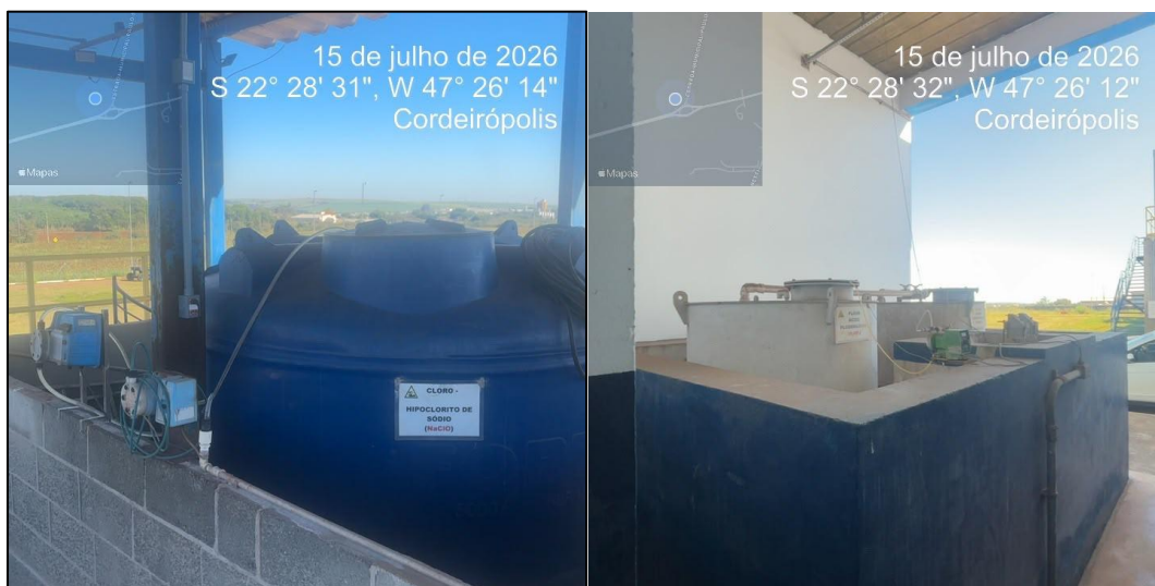
Figura 10 – Compartimentos para armazenamento de insumos como cloro, CAL, coagulante e flúor.
