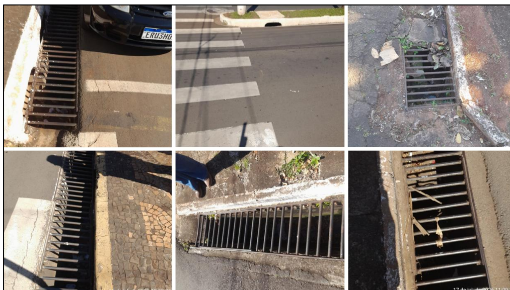
Figura 65 – Dispositivos de microdrenagem em Cordeirópolis.
