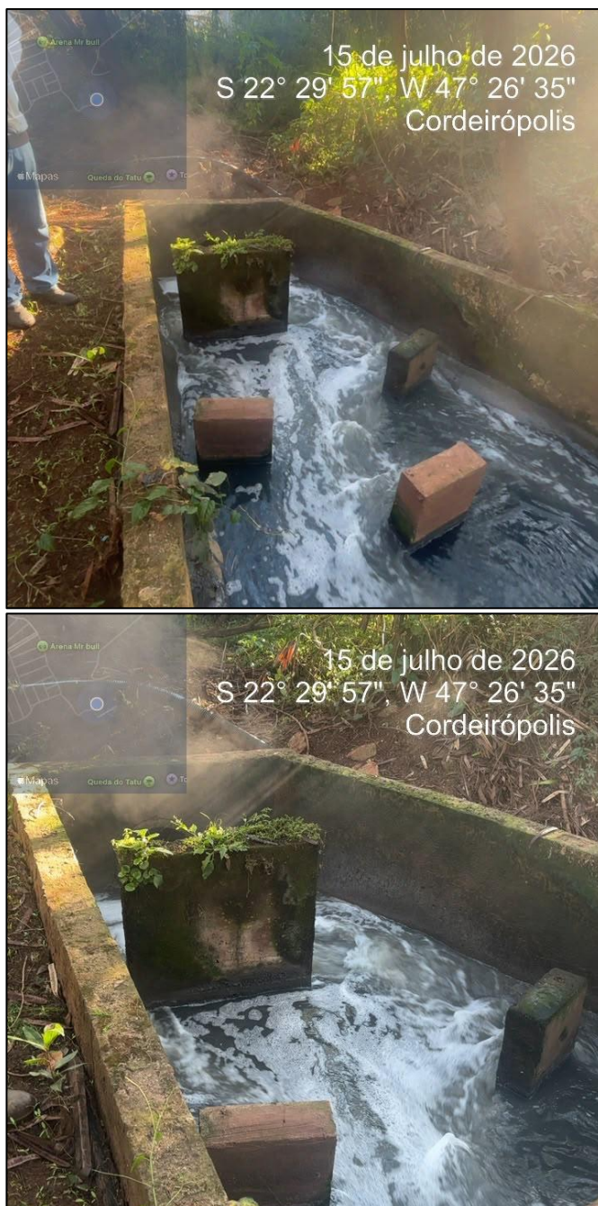
Figura 25 – Escada Dissipadora de Energia.
