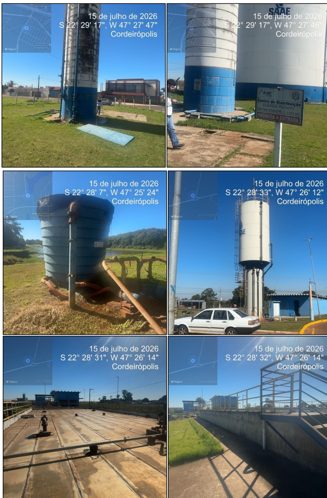
Figura 15 – Reservatórios de abastecimento de água em Cordeirópolis.
