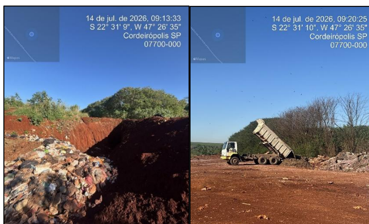
Figura 56 - Aterro Sanitário em Valas onde ocorre a disposição final dos resíduos de Cordeirópolis.
