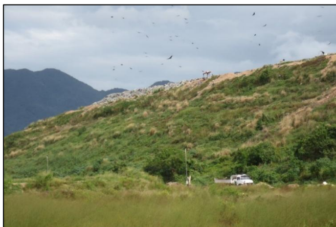
Figura 63 - Exemplo de aterro controlado.
