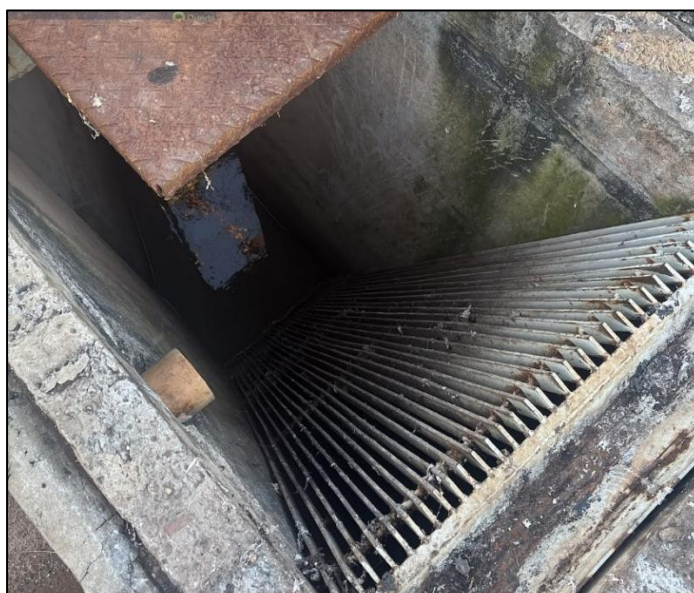
Figura 18 – Sistema de gradeamento.
